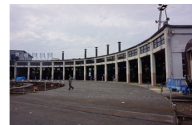
図3. 梅小路蒸気機関車庫 4)
